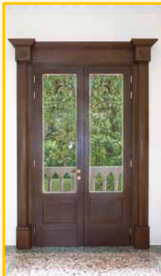
Particolare da restauro in villa, porta d'affaccio sul terrazzo riprodotta fedelmente all'originale.
