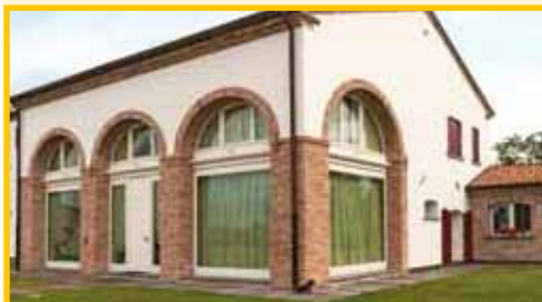
Particolare realizzazione di vetrate con sormonto di finestra ad arco ribassato. Venezia, trifore realizzate su cantiere di restauro conservativo in palazzo storico.
