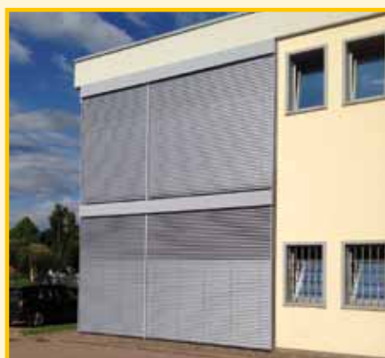
Facciata della sede di Paggiarin sulla quale è stato installato un frangisole con sistema TLT, che permette di orientare le lamelle in due direzioni distinte
