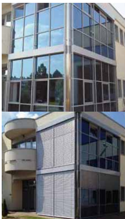
PAGGIARIN, sede aziendale: posa di frangisole in facciata con sistema TLT di orientamento della luce, per il direzionamento ottimale della luce diurna.
