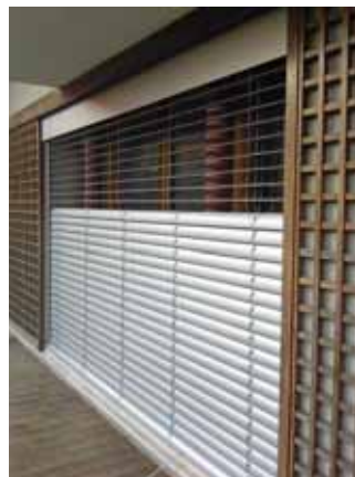
Sistema TLT: dispositivo di orientamento della luce diurna per il direzionamento ottimale della luce.
