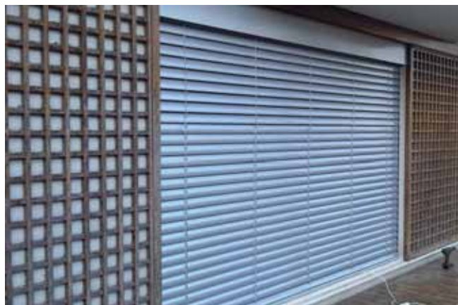
Sistema TLT: dispositivo di orientamento della luce diurna per il direzionamento ottimale della luce.
