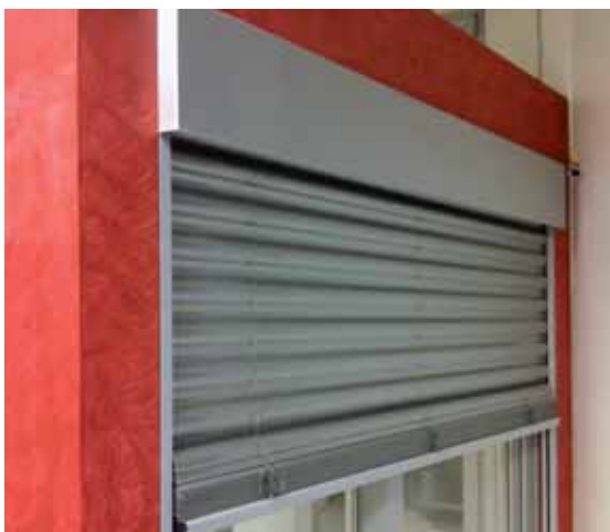
Sistema TLT: dispositivo di orientamento della luce diurna per il direzionamento ottimale della luce.
