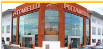
A sinistra: realizzazioni in vetro e acciaio su facciate e progetti industriali. Particolari di bussola d'ingresso.
