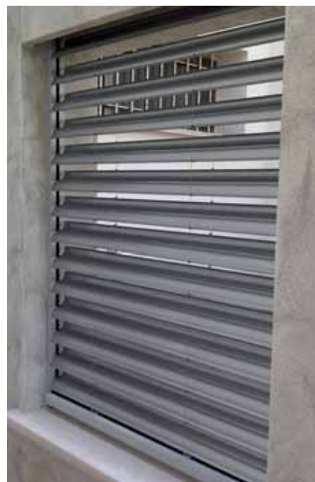
Sistema TLT: dispositivo di orientamento della luce diurna per il direzionamento ottimale della luce.
